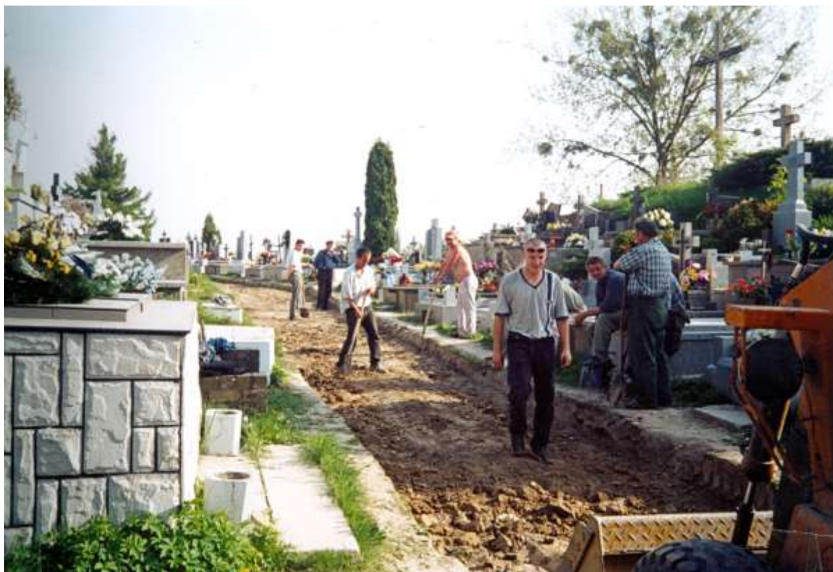
Zdjęcie 176 – Rok 2003, maj. Układanie chodnika na głównej alejce cmentarza (zdjęcie z KPK T 2).
