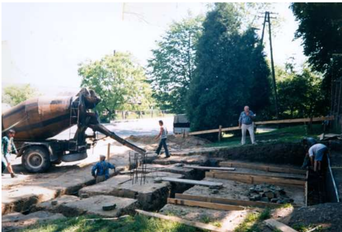
Zdjęcie 137 – Rok 1998. Budowa nowych schodów do kościoła (zdjęcie z KPK T1).
