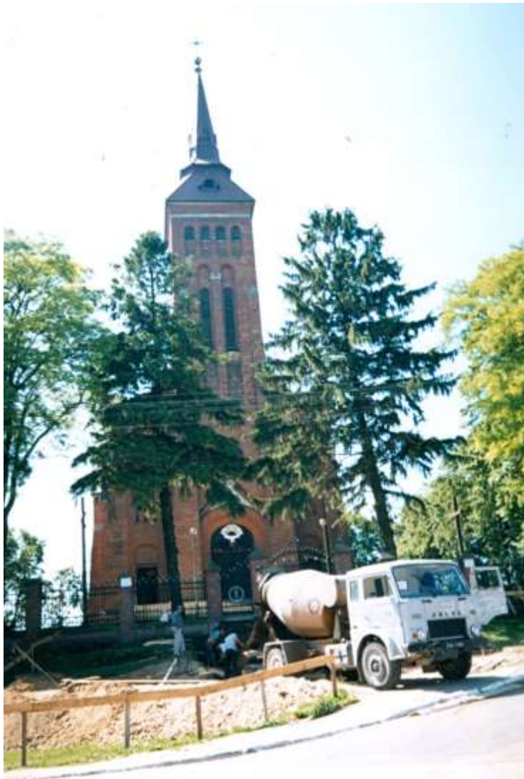
Zdjęcie 138 – Rok 1998. Budowa nowych schodów do kościoła (zdjęcie z KPK T1).
