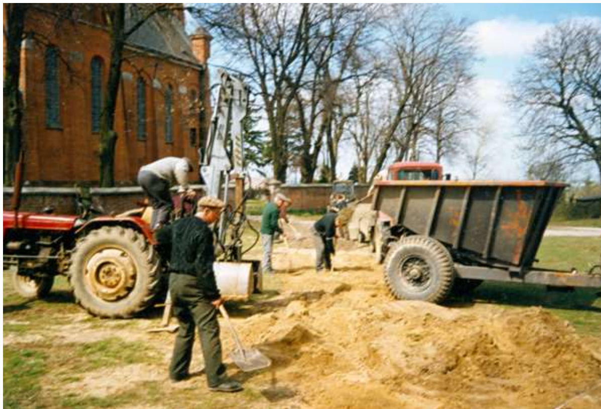
Zdjęcie 175 – Rok 1998. Budowa bocznej drogi na cmentarz (zdjęcie z KPK T1).
