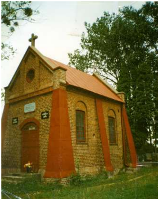
Zdjęcie 189 – Rok 1997. Kaplica cmentarna po konserwacji blachy (zdjęcie z KPK T1).
