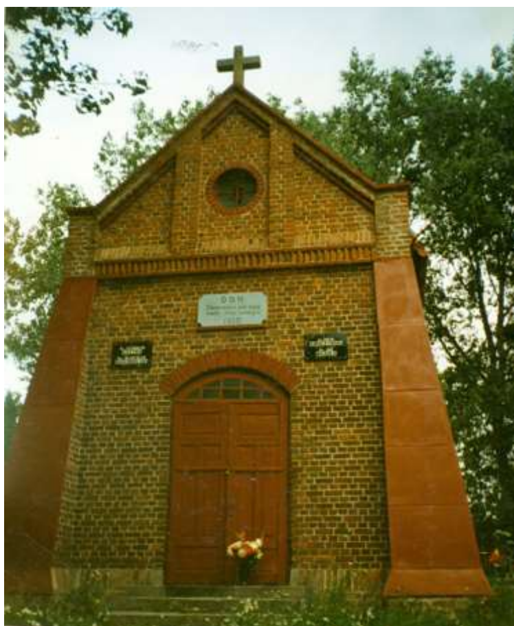
Zdjęcie 190 – Rok 1997. Kaplica cmentarna po konserwacji blachy (zdjęcie z KPK T1).
