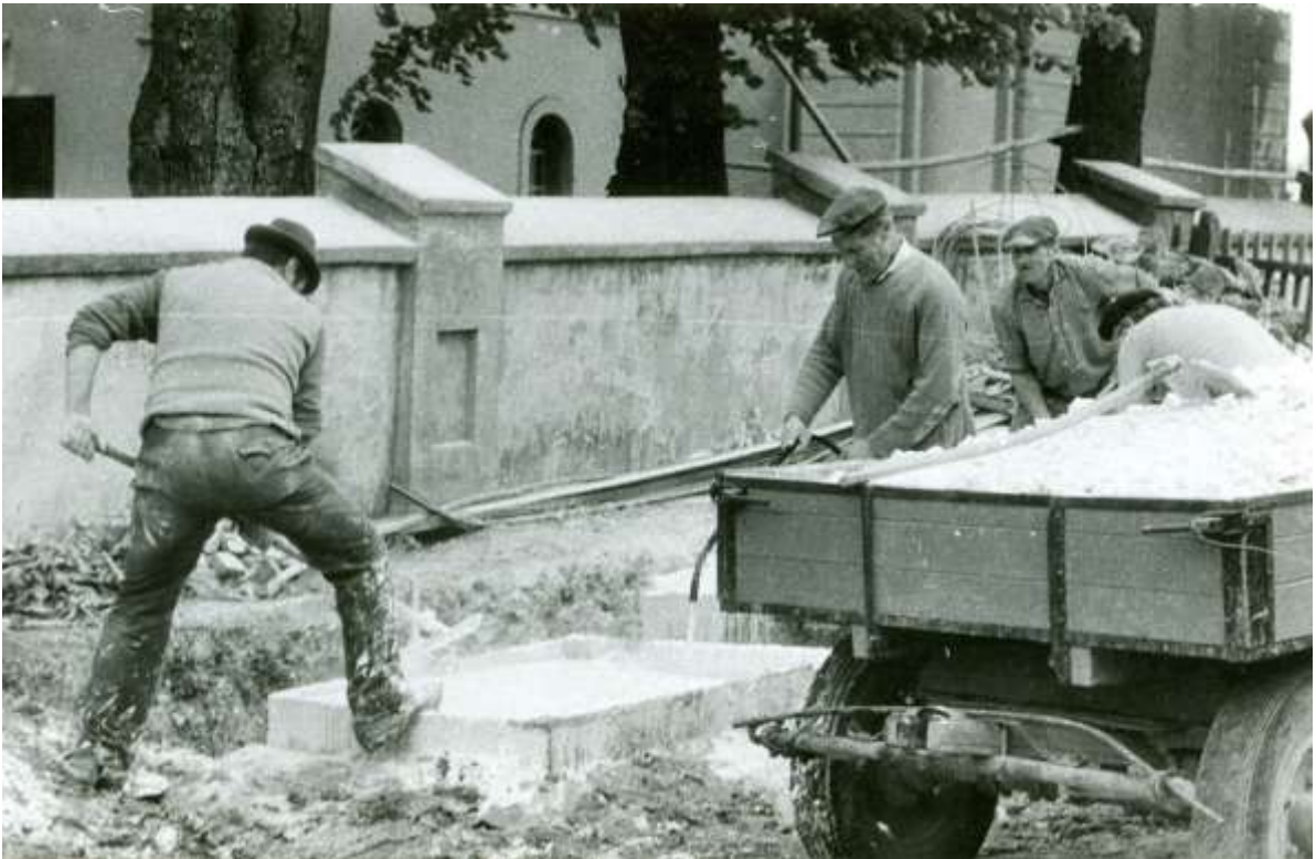
Zdjęcie 185 – Rok 1976, czerwiec. Budowa plebanii, lasowanie wapna (zdjęcie ze zbiorów parafii).
