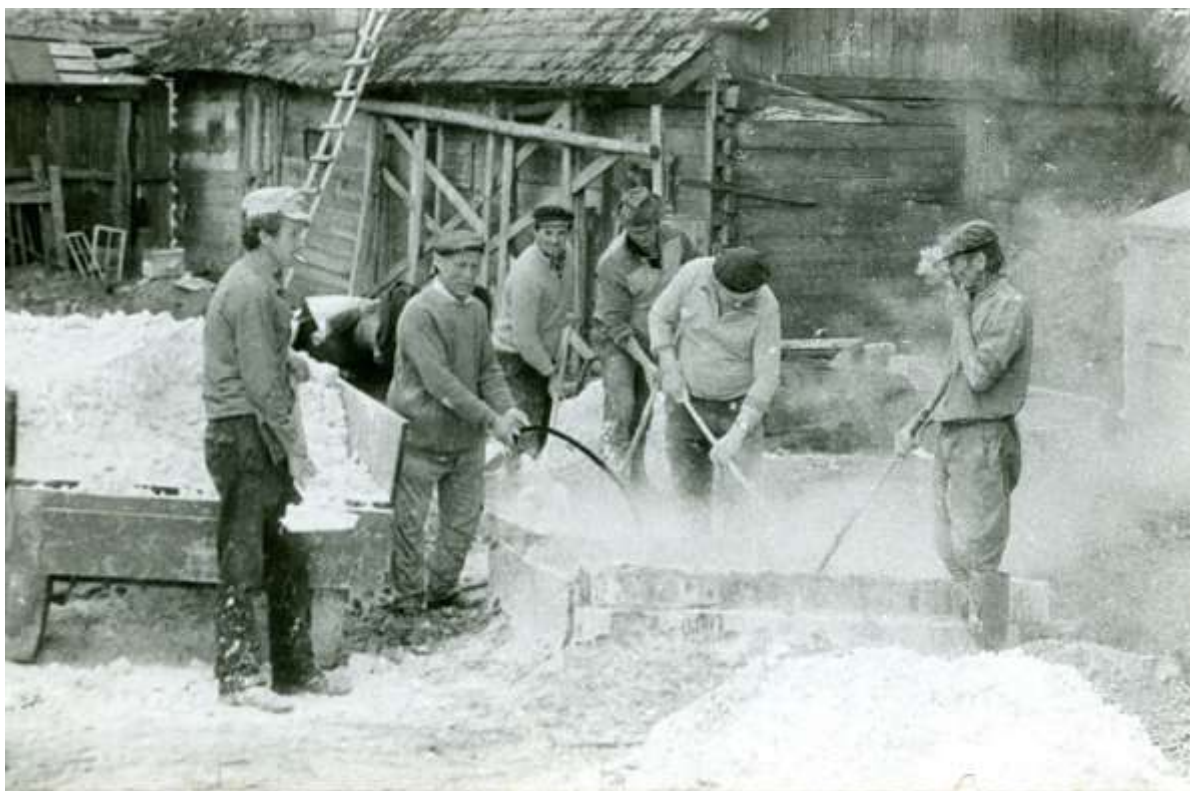
Zdjęcie 186 – Rok 1976, czerwiec. Budowa plebanii, lasowanie wapna (zdjęcie ze zbiorów parafii).
