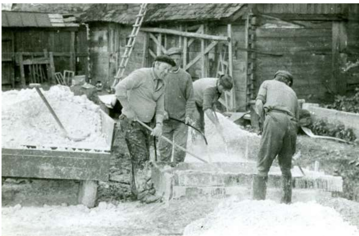
Zdjęcie 187 – Rok 1976, czerwiec. Budowa plebanii, lasowanie wapna (zdjęcie ze zbiorów parafii).
