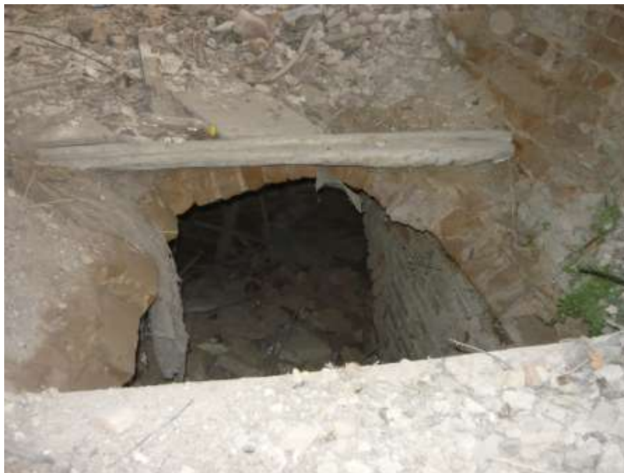
Zdjęcie 41 – Rok 2013, 25 sierpnia. Przebite przejścia do podziemi. Foto Mateusz Skórzewski.
