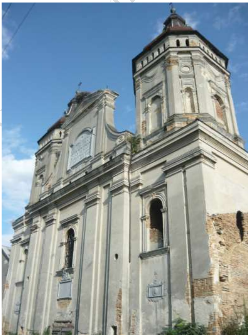
Zdjęcie 37 – Rok 2013, 25 sierpnia. Frontowa ściana kościoła św. Marka w Warężu (w porównaniu do pozostałej części budynku w dość dobrym stanie, foto Mateusz Skórzewski).
