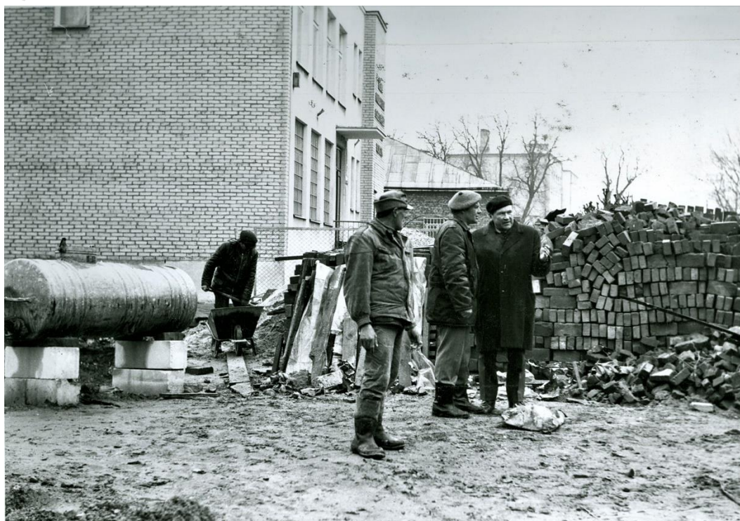
Zdjęcie 42 – Rok 1977, jesień. Grabowiec. Plac budowy siedziby urzędu gminy, przy ulicy Rynek. Sekretarz biura UG Grabowiec Bolesław Grechuta (z podniesioną ręką) rozmawia z kierownikiem budowy Kazimierzem Pieczykolanem. W tle widoczne są budynki: siedziba banku, dom Czesława Kulika, budynek szkoły. Foto Tadeusz Halicki. Zdjęcie z kroniki gminy Grabowiec.
