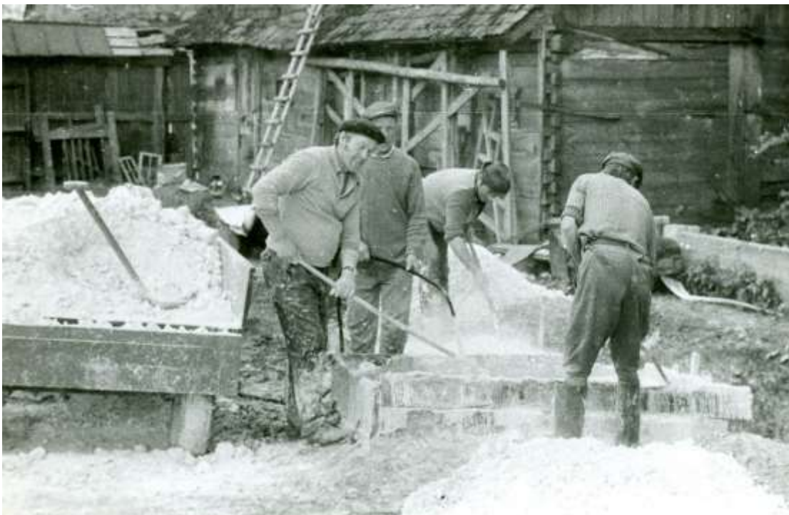
Zdjęcie 10 – Rok 1976, czerwiec. Budowa plebanii, lasowanie wapna (zdjęcie ze zbiorów parafii).
