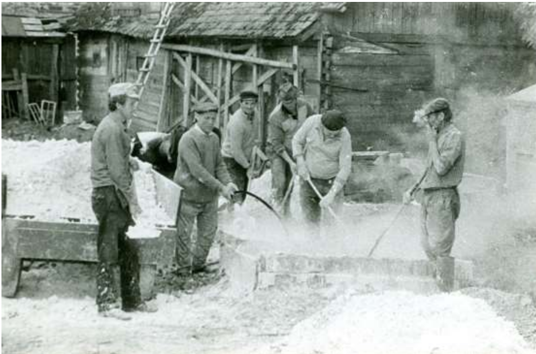
Zdjęcie 9 – Rok 1976, czerwiec. Budowa plebanii, lasowanie wapna (zdjęcie ze zbiorów parafii).
