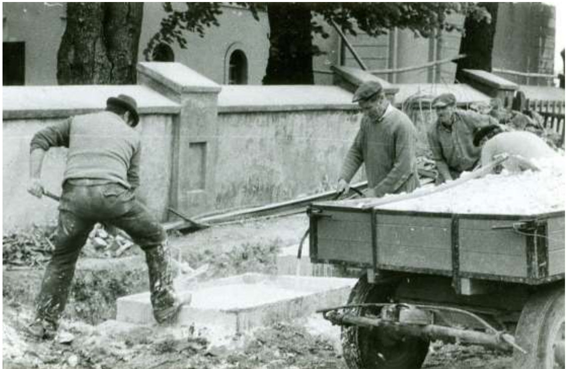
Zdjęcie 8 – Rok 1976, czerwiec. Budowa plebanii, lasowanie wapna (zdjęcie ze zbiorów parafii).
