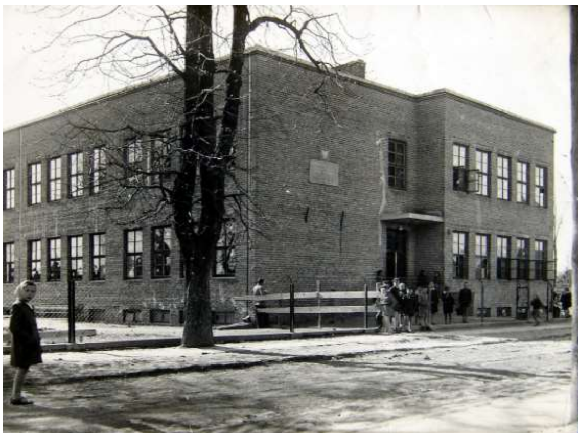
Zdjęcie 4 – Rok 1957 (około). Budynek szkoły w okresie rozbudowy trwającej w latach 1957-1961. Widoczne na placu szkolnym wytyczenia fundamentów pod lewe skrzydło budynku. Nawierzchnia ulicy Wojsławskiej nie jest jeszcze asfaltowa. Zdjęcie z kroniki szkolnej.
